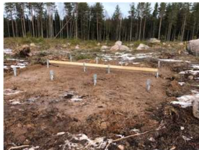
Växelriktarhuset påbörjat innan det kom mer snö 3 mars
