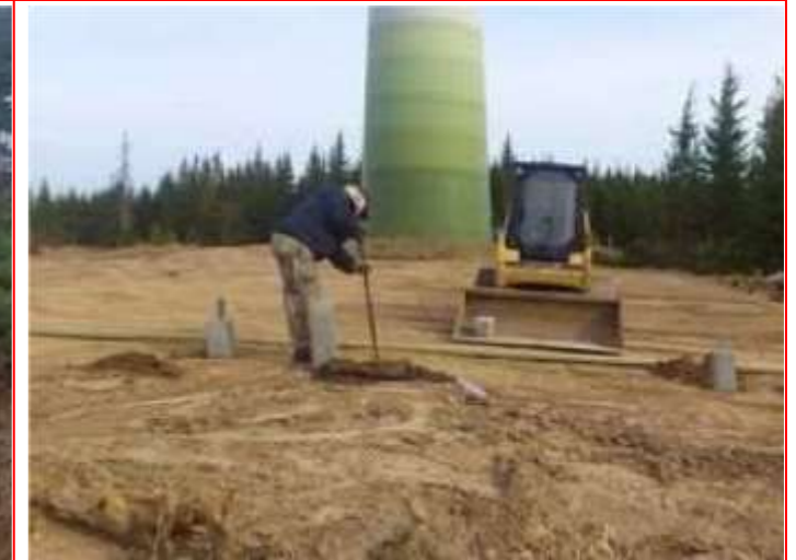
Sten monterar fundament
