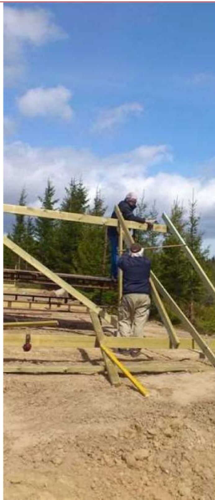
Håkan och Sten monterar ställning
