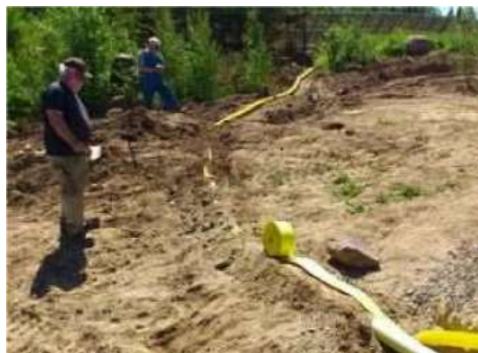
Markeringsremsor som skydd innan återfyllning
