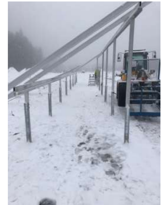
Montering av det första "bordet"
