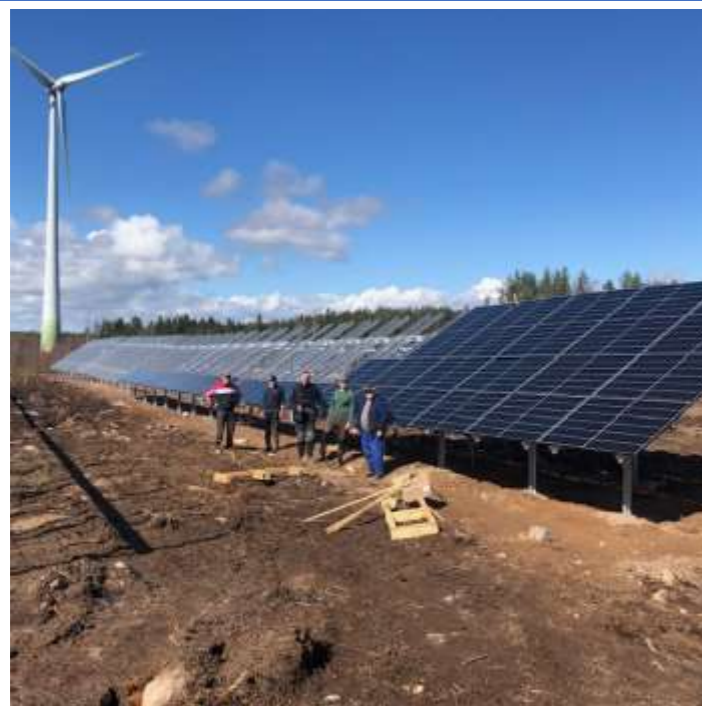
1:a solcellerna monterade 12 april
