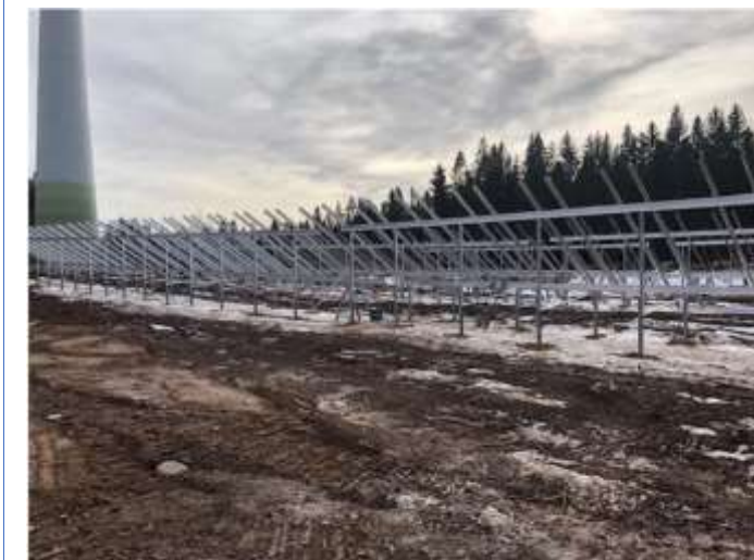
Många ställningar som nu börjar bli färdiga för montering av solcellerna
