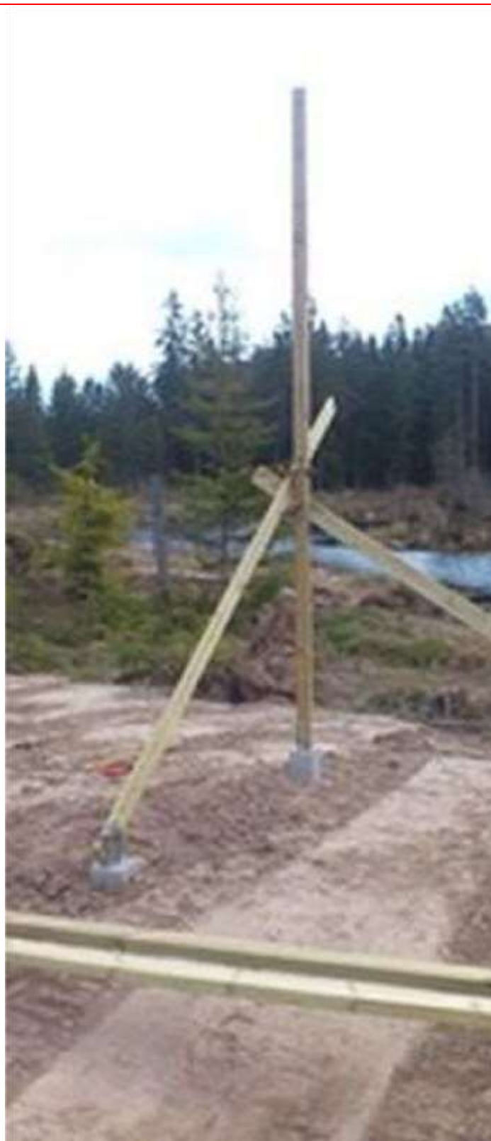
1:a hörnstolpen monterad
