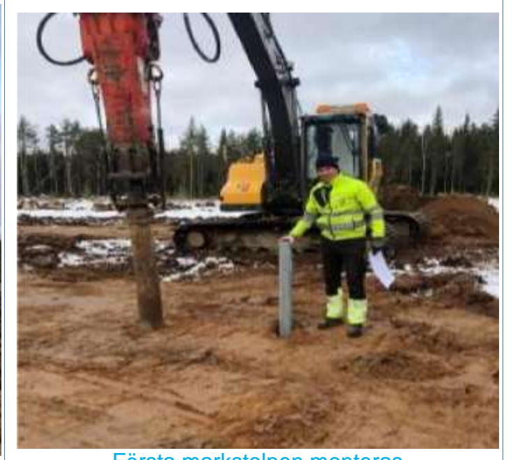
Första markstolpen monteras
