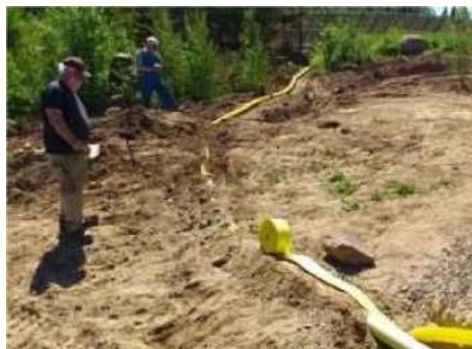
Markeringsremsor som skydd innan återfyllning
