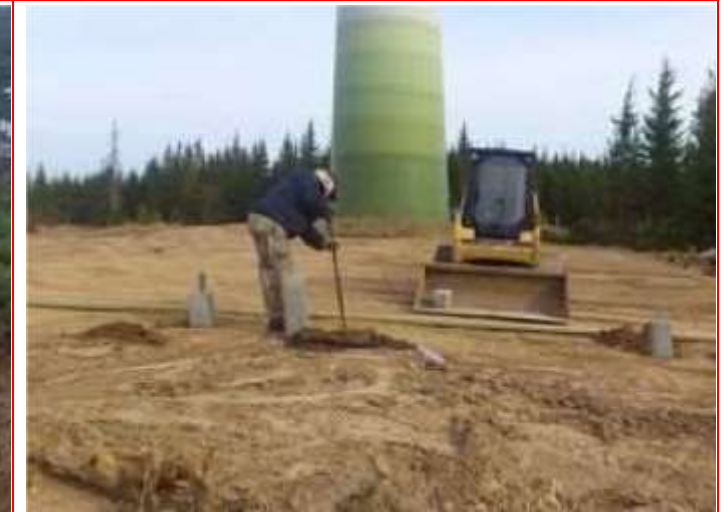
Sten monterar fundament
