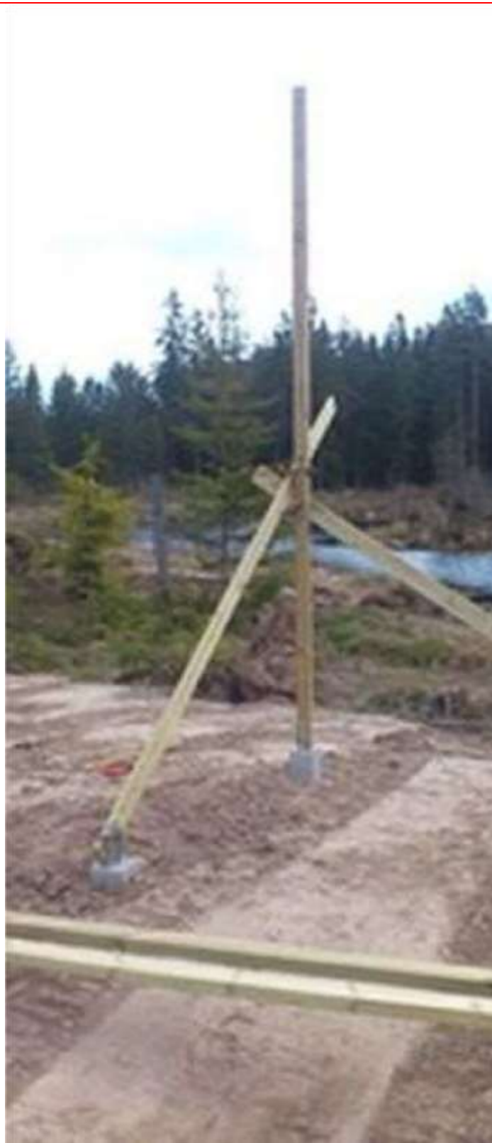
1:a hörnstolpen monterad
