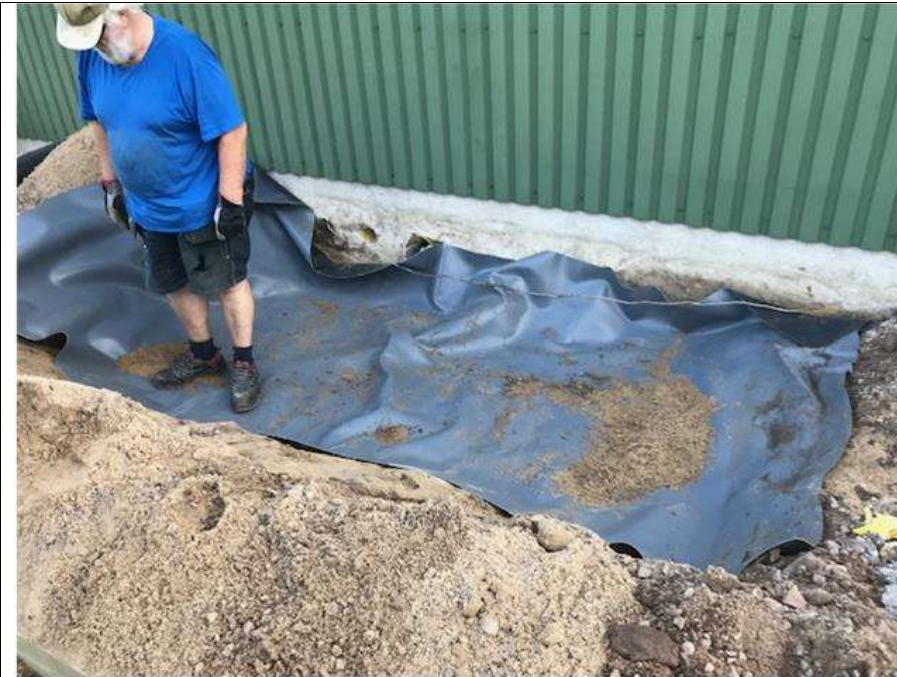
Sten inspekterar gummiduken som ska vara ett skydd för eventuella oljeläckage.
