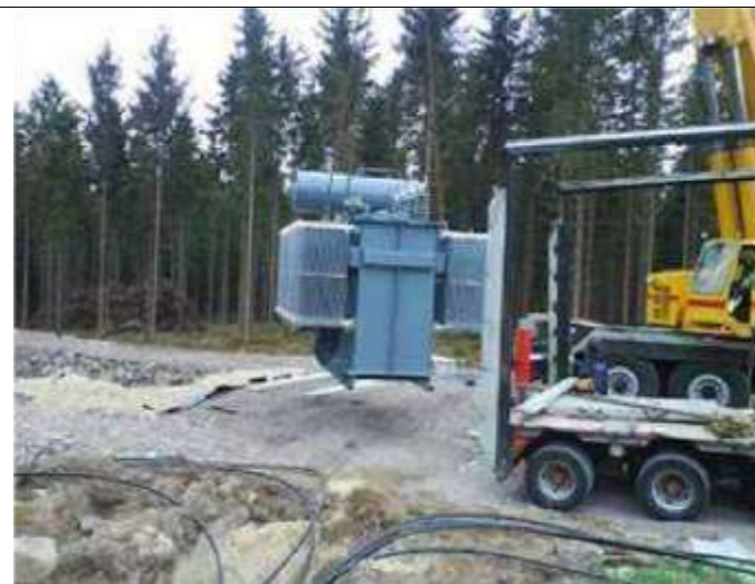
40 kV Transformatorn lyfts på plats
