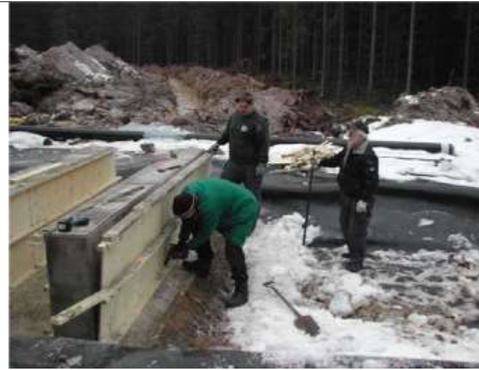
Rivning av form för 40 kV transformator
