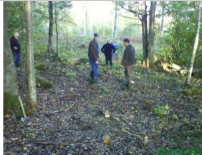
Röjning av skog för ledningen vid Åkarp
