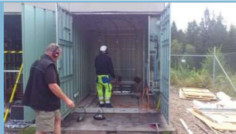
Brytarskåpet är rensat på den trasiga brytaren
